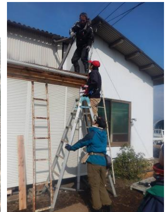
屋根の雨漏りを修繕中
