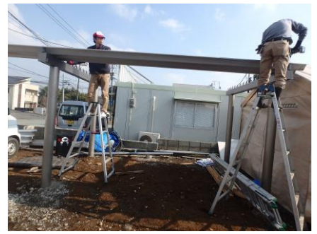
既存の車庫の解体作業
