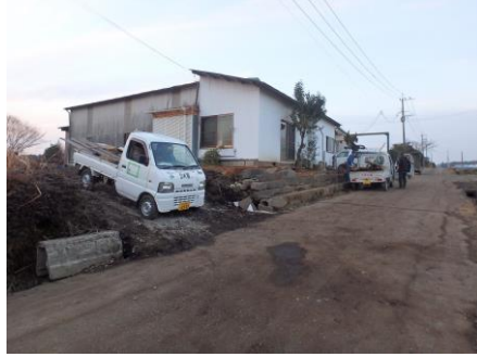
作業が終了した頃には夕暮れが近づく
